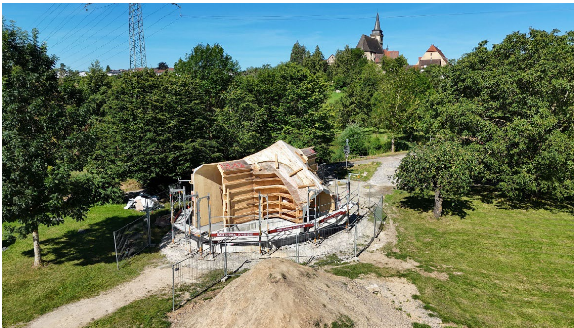
Abbildung 43: Re-Use-Baukomponenten von Betonschalungen für neue Bauaufgaben. Fotos: Kretzer/Forschungsteam Stuttgart 210
